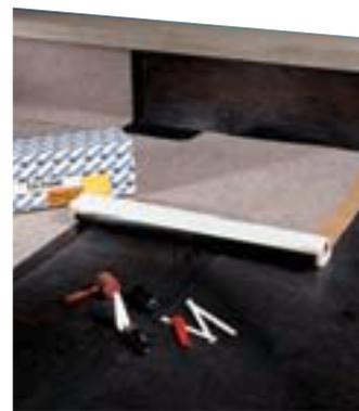
des carreaux, on intercale une couche de désolidarisation en non-tissé. Un polyane est déroulé dessus avant mise en œuvre du béton ou du mortier de scellement (Paradiene de Siplast, Colphène de Soprema).
